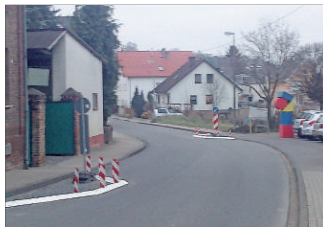
Seit dem 20. Dezember 2016 sorgen die Fahrbahnverengungen in der Lambertstraße für einen ruhigeren Verkehrsfluss. Foto: privat
