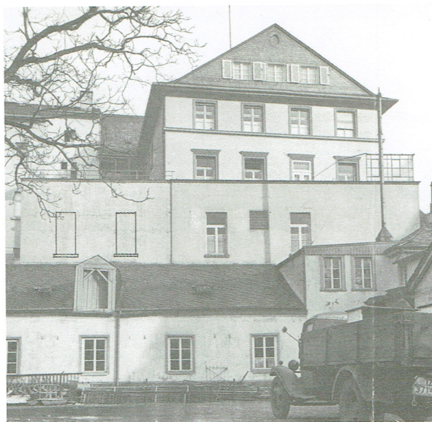
Gestapogebäude „Im Vogelsang“ 1-3. Rückwärtige Ansicht. Die Aufnahme entstand um 1935.
