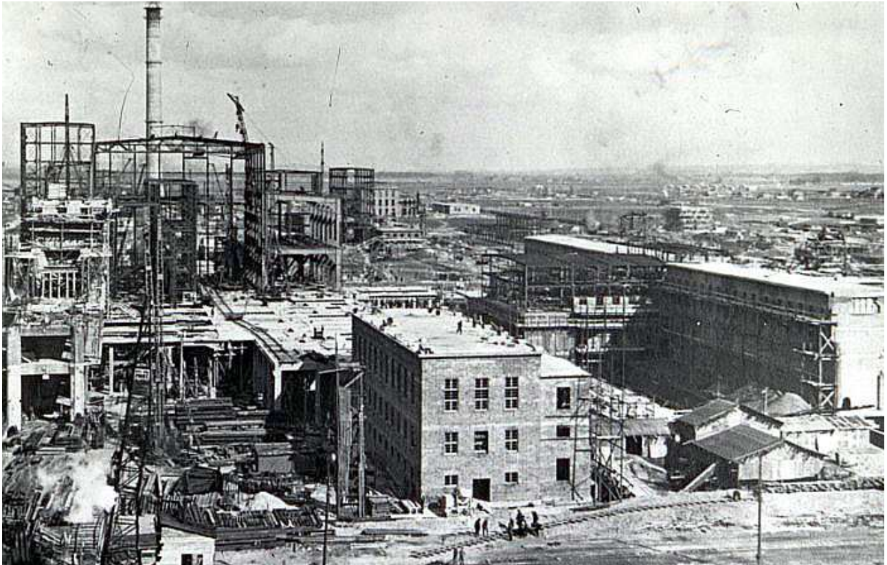
Großbaustelle des IG Farbenwerk in Auschwitz Monowitz, nur einige hundert Meter vom KZ Auschwitz-Monowitz entfernt.
